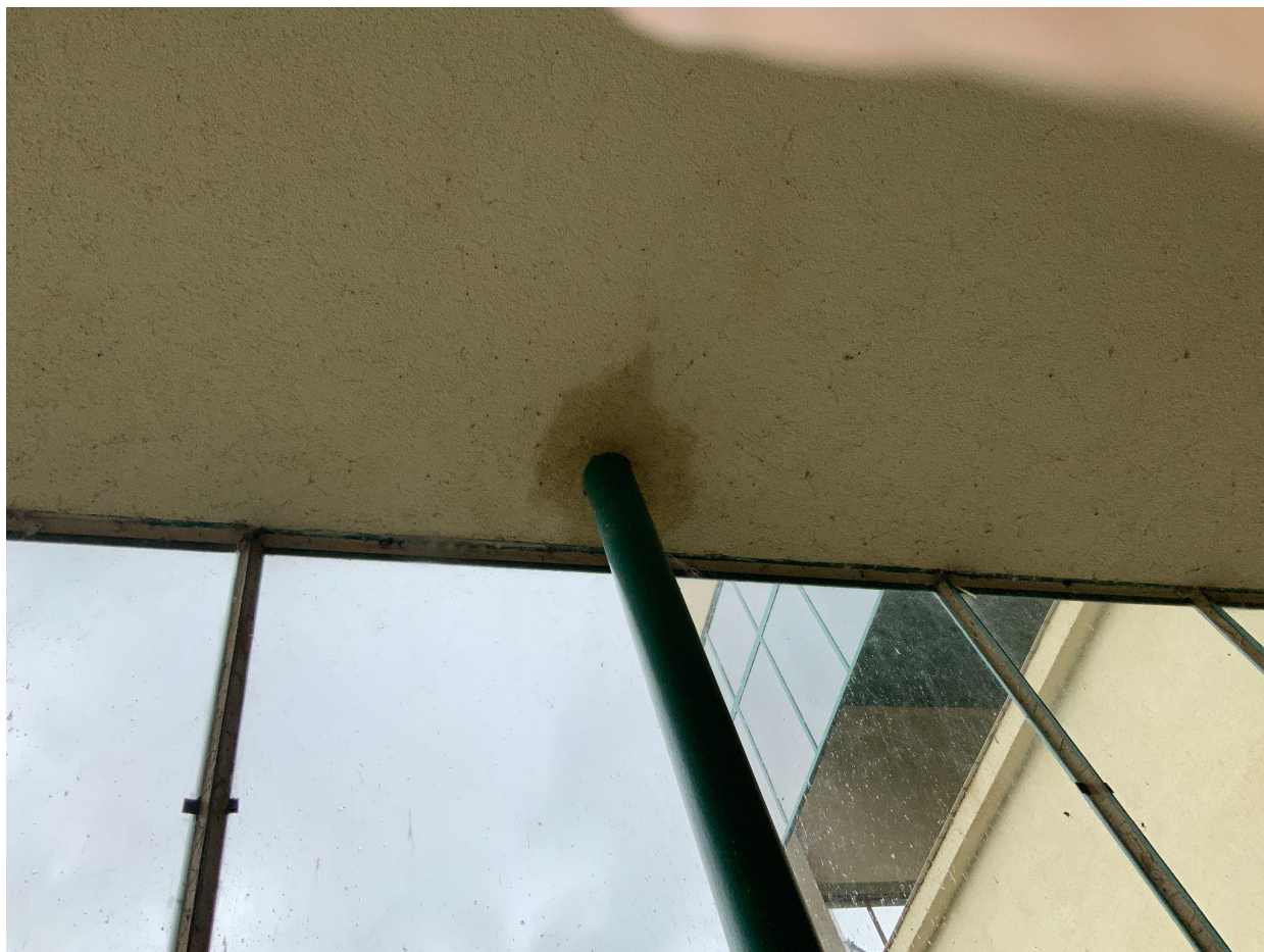
Obr. Stříška nad vstupem - zvlhnutá omítka pod vpustí
